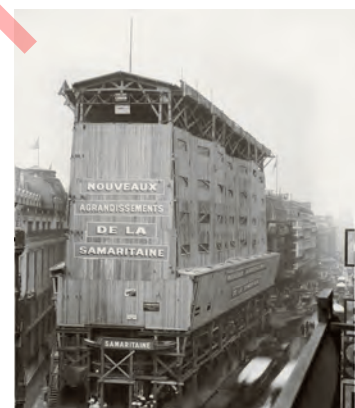
Construction du magasin 3
