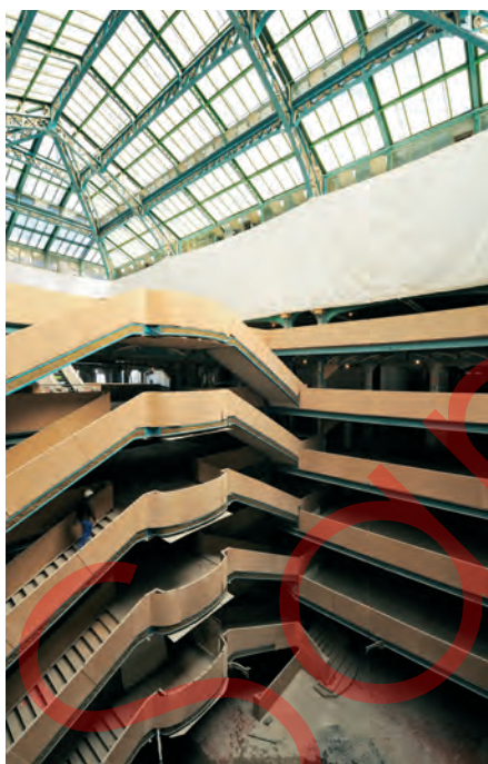
Chantier de désamiantage et curage 2010
