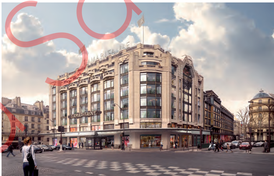
Façade rénovée du bâtiment « Sauvage » quai de Loire
