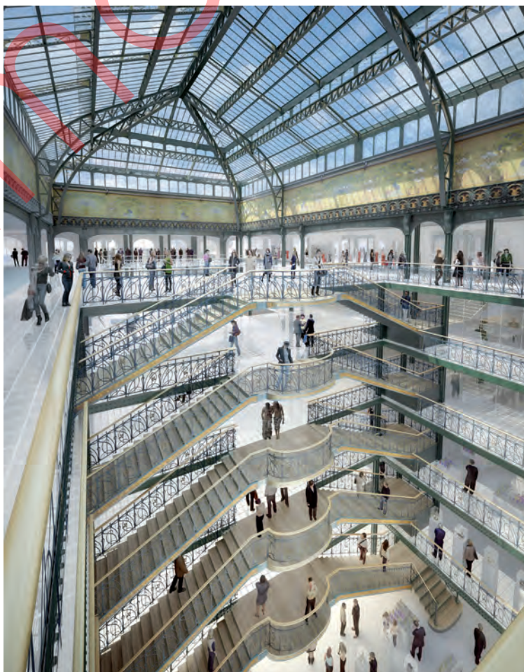
Le Hall Jourdain et sa verrière entièrement restaurée
