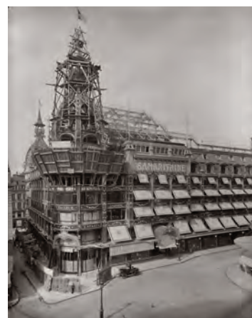
Façade rue de la Monnaie, les coupoles d'angle seront démolies au moment de l'extension quai du Louvre
