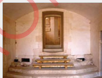
La séquence d'accès, les entrées de lumière et le traitement architectural des paliers infléchit la rigueur de la cage d'escalier à noyau ajouré.
