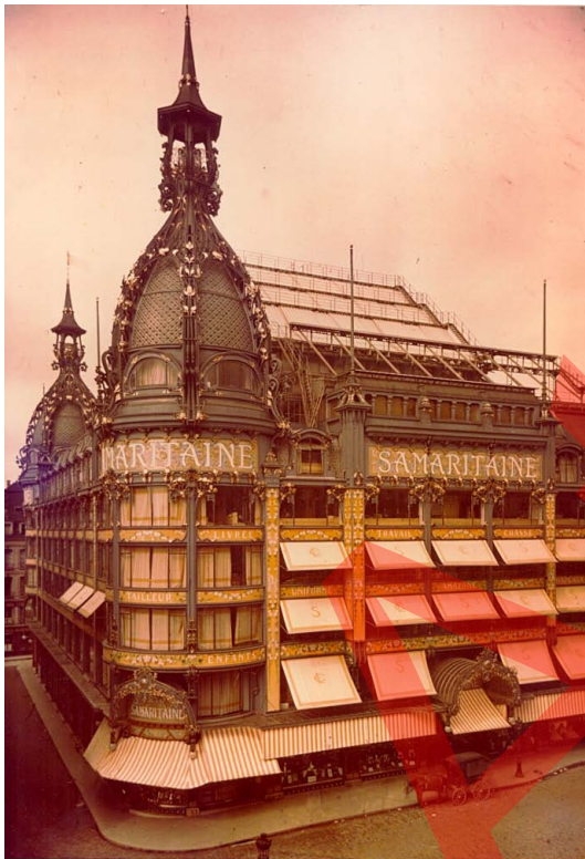
En haut - Verre avec protection solaire sur la rue de l'Arbre Sec - Cliché Attrapa - Février 2011 En bas - Angle rue des Prêtres et rue de la Monnaie vers 1907, stores en façade et en superstructure au-dessus de la verrière - Archives Meredith Clausen
