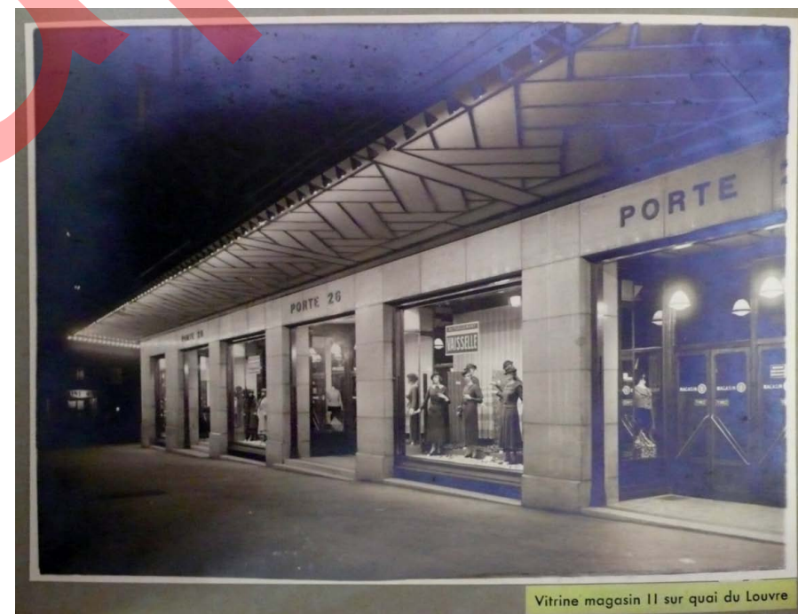
Magasin 2 - Extension Sauvage - Eclairage artificiel des marquises Archives de la Samaritaine, Services Travaux
