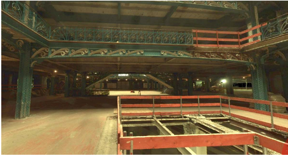
Magasin 2 - Verrière Jourdain - Structure de la passerelle centrale du hall Image extraite du scan 3D TARTACEDE - 2011
