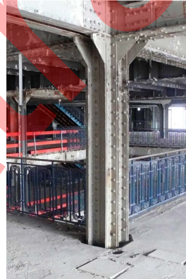
Magasin 2 - de gauche à droite - Plateaux Jourdain, Verrière Jourdain, Extension Sauvage - Permanence du poteau à plan cruciforme Clichés Attrapa - février 2011
