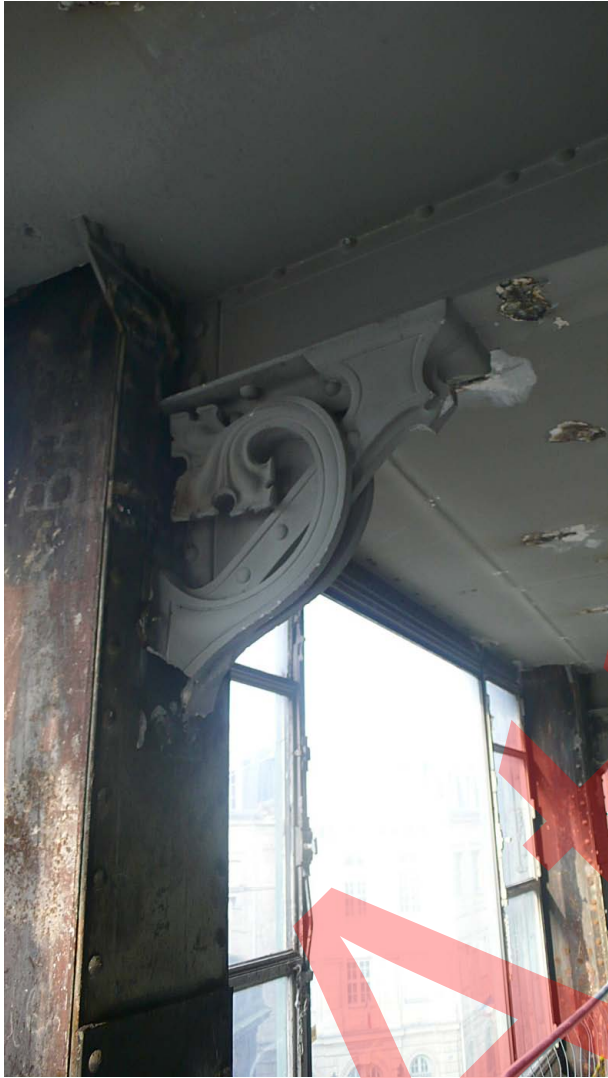
Magasin 2 - Plateaux Jourdain - Consoles en plâtre d'habillage et de protection des structures métalliques. Différents états après les démolitions Clichés Attrapa - Février 2011
