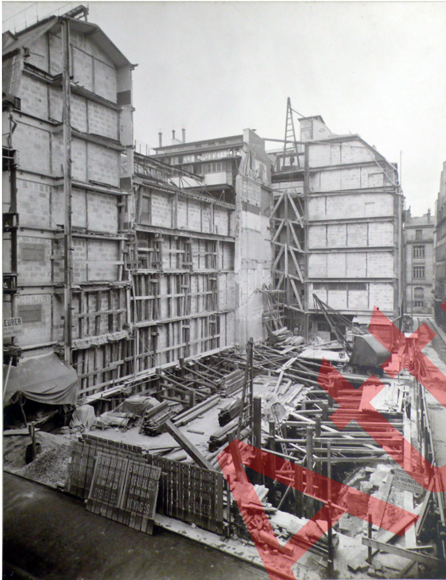
Chantier à l'angle des rues de la Monnaie et Baillet - S.D. Cliché Attrapa 500-01_473
