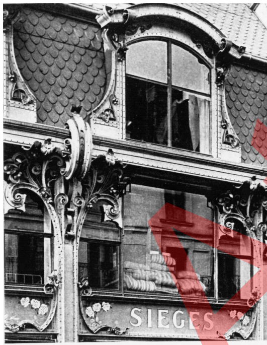
Détail du motif en écailles de la couverture Extrait de Barre-Despond A., op. cit.
