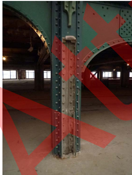
Magasin 2 - de gauche à droite - Plateaux Jourdain, Verrière Jourdain, Extension Sauvage - Permanence du poteau à plan cruciforme Clichés Attrapa - février 2011
