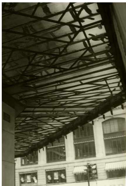
Magasin 2 - Marquise avant travaux, circa 1953 IFA Fonds Charpentier - Caisse 110
