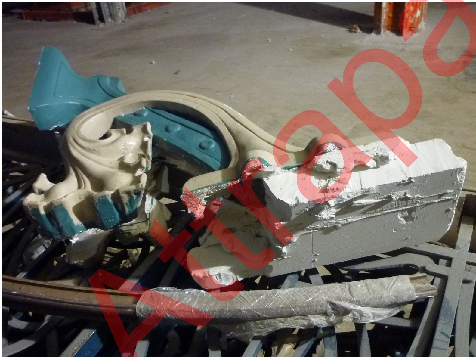
Décor en plâtre imitant les rivets du métal Cliché Attrapa - Février 2011
