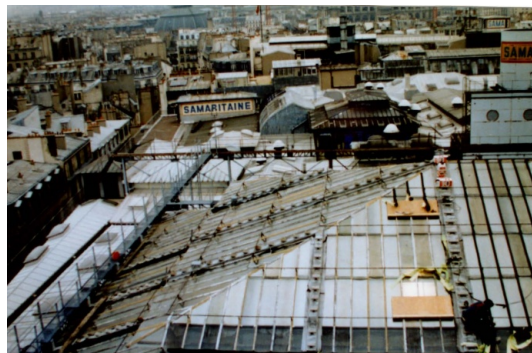
Les toits de la Samaritaine avant la restauration de la grande verrière en 1986. A noter la cheminée "de bateau" de 1948 qui disparaît à cette occasion Archives de la Samaritaine, Service Travaux
