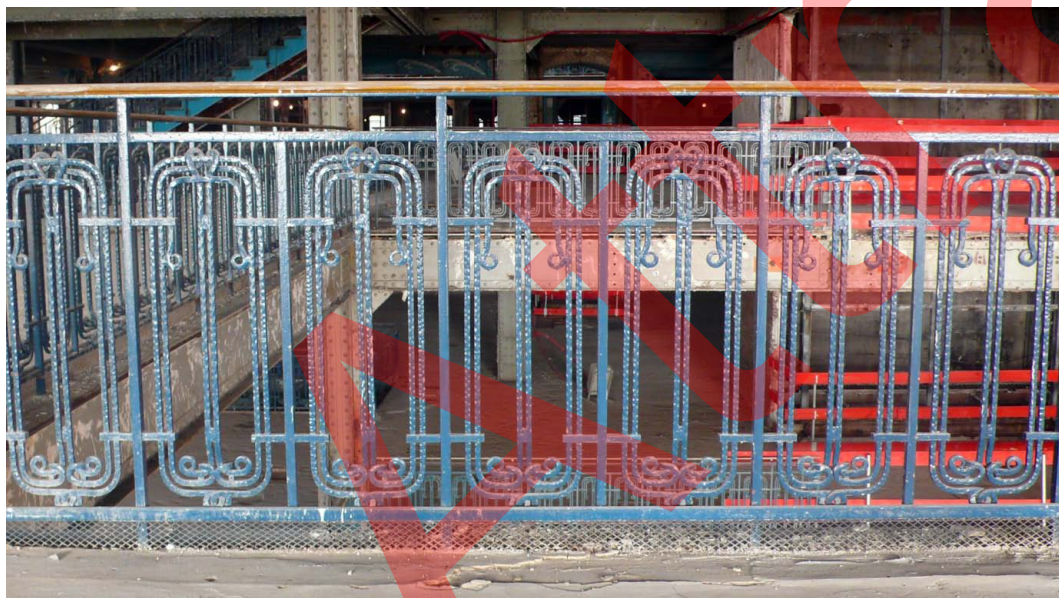
Magasin 2 - Extension Sauvage - Détail du rebouchement du hall - Détail des ferronneries Clichés Attrapa - Février 2011
