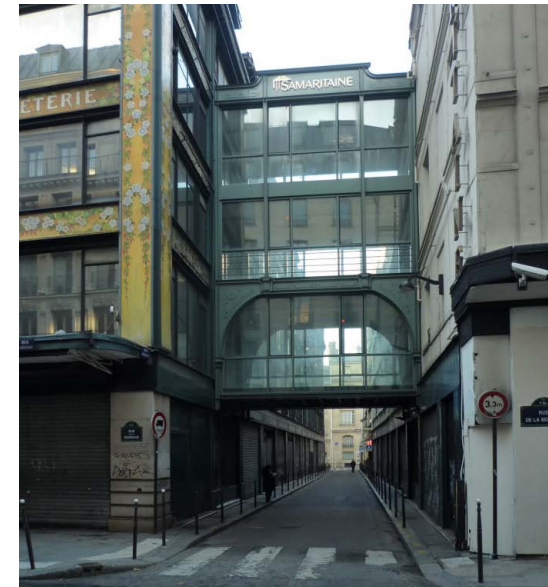
Passerelle rue Baillet Cliché Attrapa - Février 2011
