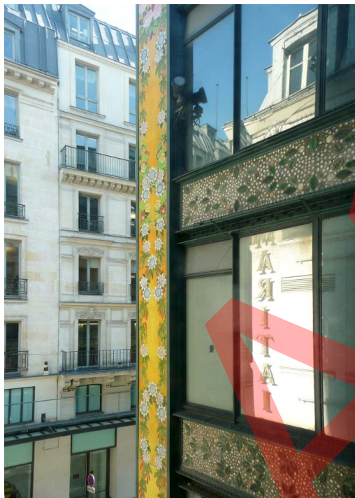
Magasin 2 - Façade rue Baillet - Les panneaux de lave émaillée sont remplacés par des grès de Bigot Cliché Attrapa - Février 2011
