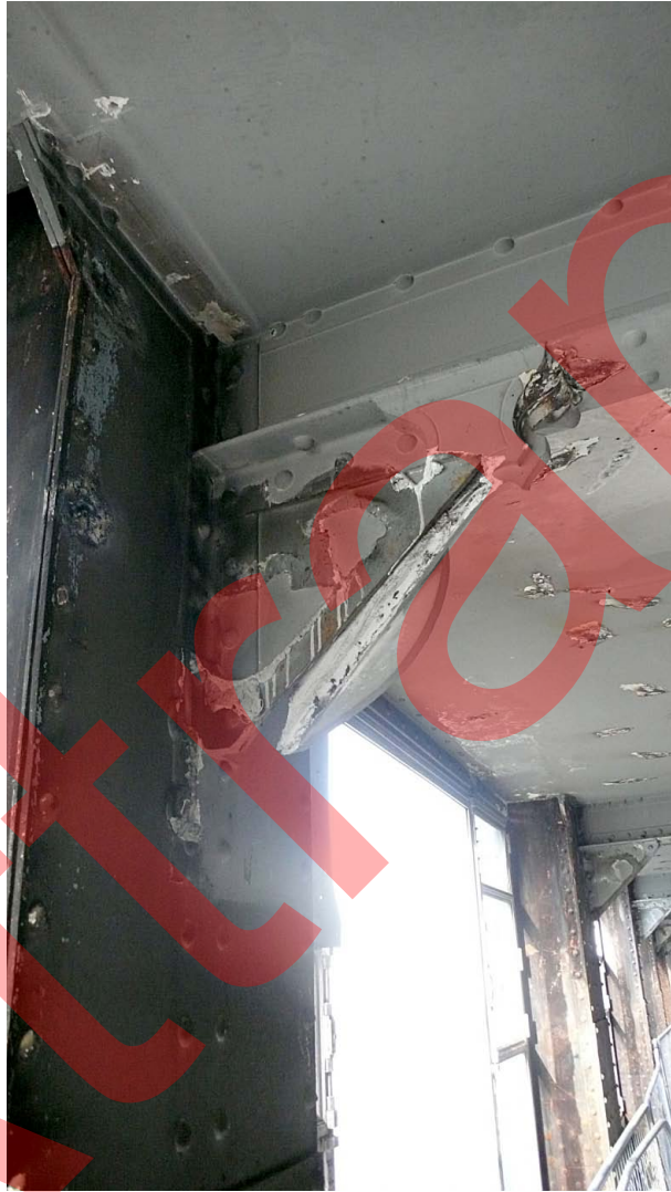
Magasin 2 - Plateaux Jourdain - Consoles en plâtre d'habillage et de protection des structures métalliques. Différents états après les démolitions Clichés Attrapa - Février 2011
