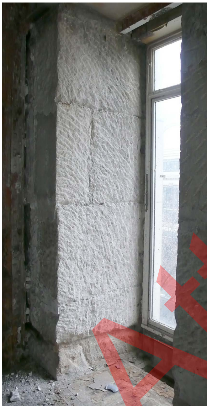
Magasin 2 - Extension Sauvage - Détail des maçonneries de pierre au droit de la structure métallique et des planchers de verre Clichés Attrapa - Février 2011
