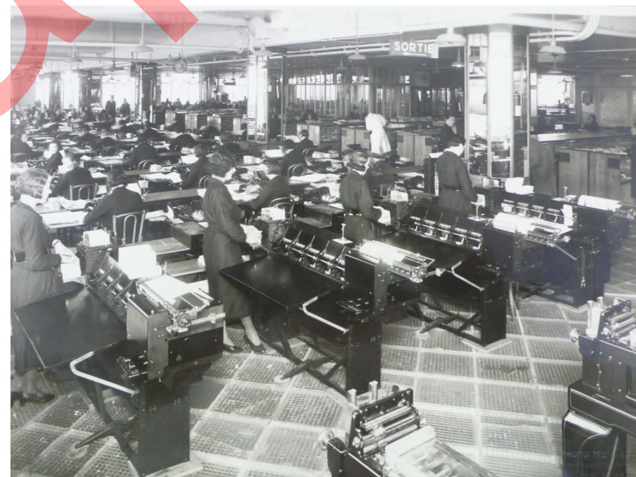
Magasin 2 - Extension Sauvage - Les bureaux. A noter les habillages des poteaux Cliché Attrapa 500-01_215 Archives de la Samaritaine, Service Travaux
