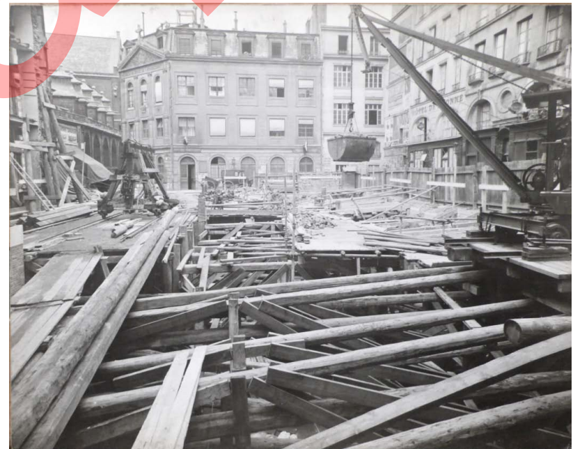
Chantier à l'angle des rues de l'Arbre Sec et Baillet - S.D. Cliché Attrapa 500-01_506
