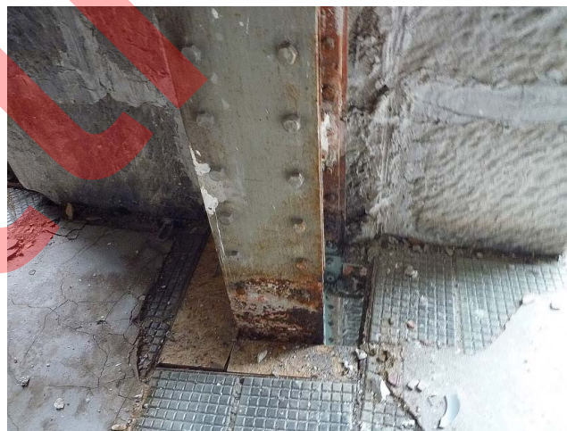
Magasin 2 - Extension Sauvage - Détail des maçonneries de pierre au droit de la structure métallique et des planchers de verre Clichés Attrapa - Février 2011
