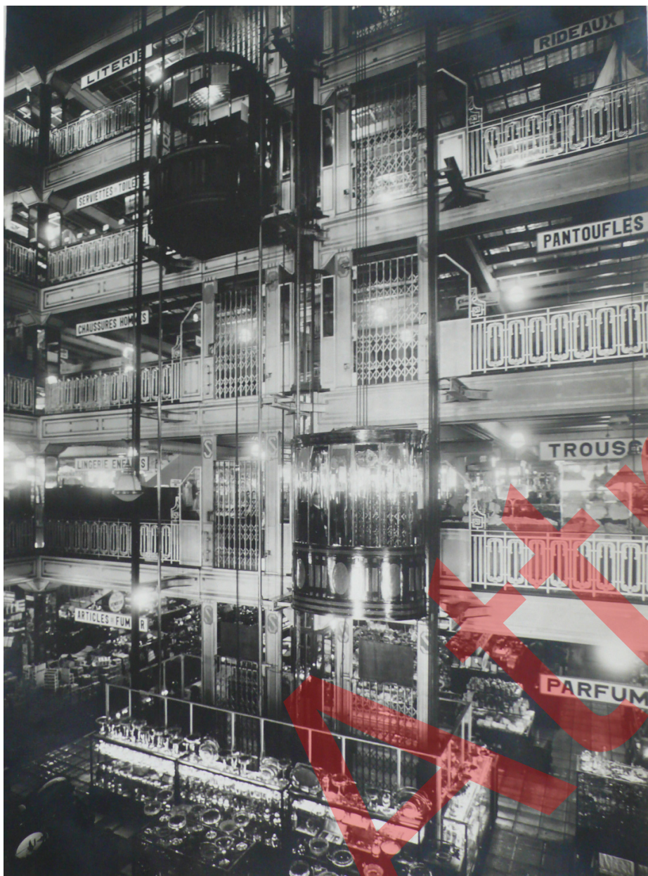
Magasin 2 - Extension Sauvage - Vue de l'atrium (circa 1930). Archives de la Samaritaine, Service Travaux
