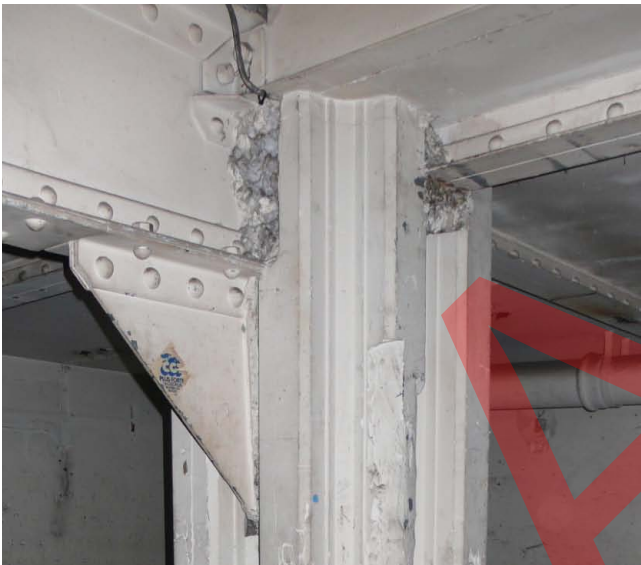
Magasin 2 - Plateaux Jourdain - Sous-sol -2b Habillage béton d'un poteau métallique. Unique vestige identifié Clichés Attrapa - Février 2011
