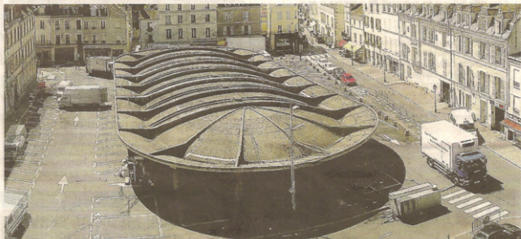
Les Bellifontains restent très attachés à la halle, et sont nombreux à craindre que le marché ne résiste pas aux deux ans de travaux
